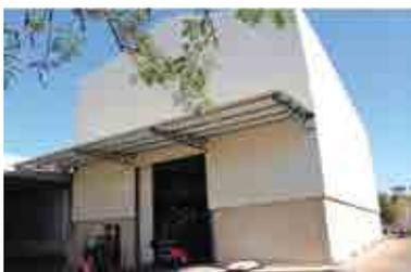
Para suprir a necessidade de estocagem com o aumento da produção nos últimos tempos, o Grupo Vittia investiu na construção de um novo galpão para estocar inoculantes. Com 530m<sup>2</sup> e altura de 13,5 metros, o galpão foi projetado para abrigar 840 pontos de armazenagem nas verticalizações, onde cada ponto tem capacidade de estocagem de 1.500kg e total para 1.260.000Kg de produtos.
